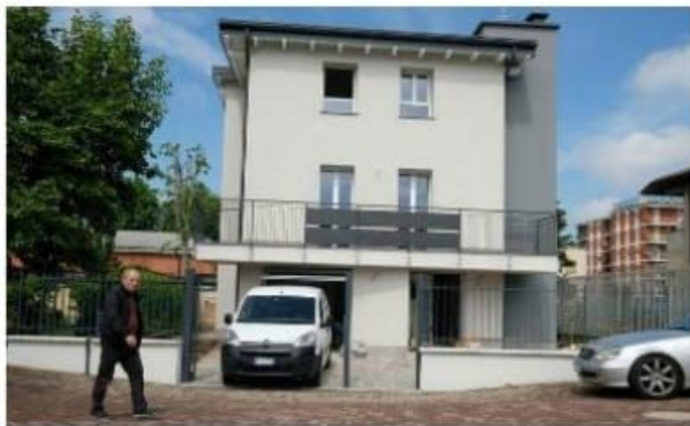
Nel cantiere di via Edison si stanno ultimando i lavori della casa
